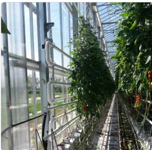
Obr. 6 Vykurovacie sústavy po obvode (1. okruh)
