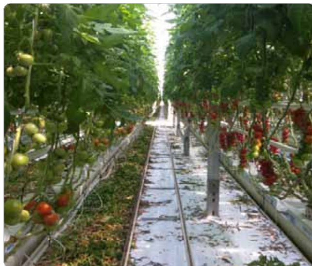
Obr. 8 Vykurovacie sústavy rúry slúžiace ako dopravník pre vozíky (3. okruh)
