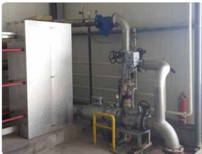
Obr. 4 Doskový výmenník tepla
