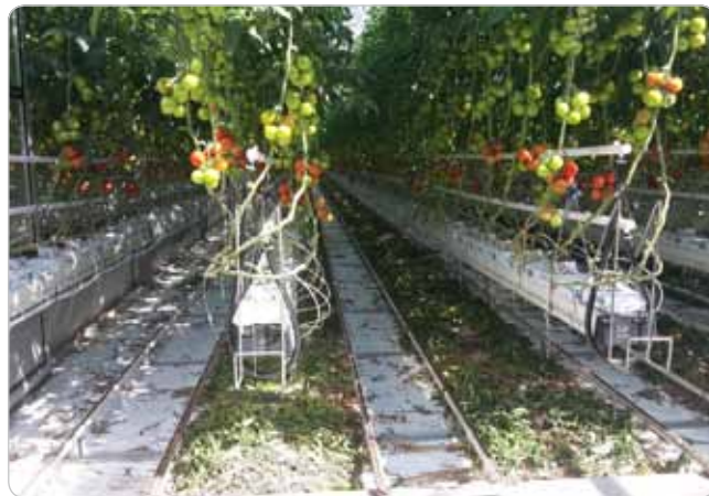
Obr. 7 Vykurovacie sústavy medzi paradajky tzv. vegetačné vykurovanie (2. okruh)
