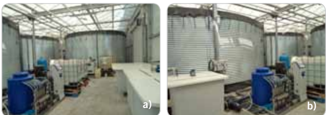
Obr. 11 Úpravňa závlhovej vody (a) a dávkovanie živín (b)
